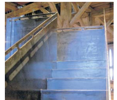
Die neue Treppe in der Artene.
